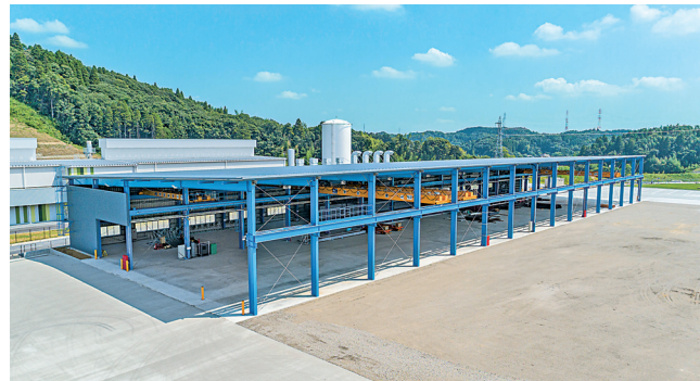
茂原工場塗装・出荷ヤード棟
